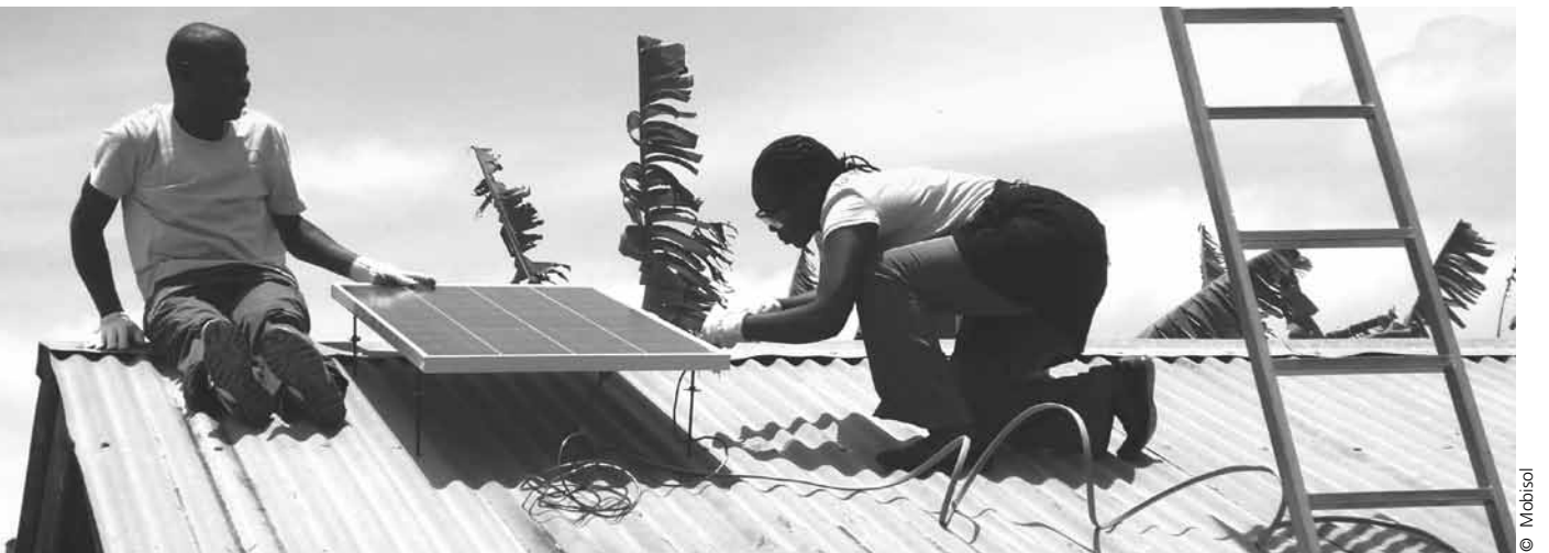
Mobisol MitarbeiterInnen beim Installieren eines Systems in Arusha/Tansania
